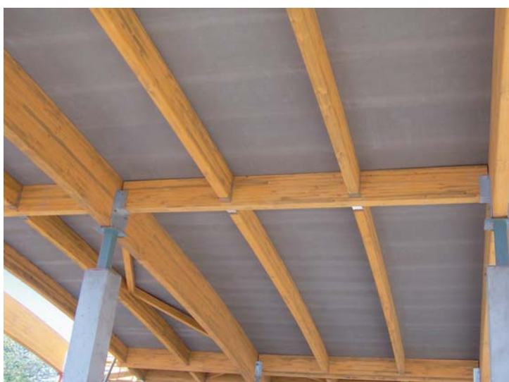
VIVIENDA UNIFAMILIAR (Logroño-La Rioja)
