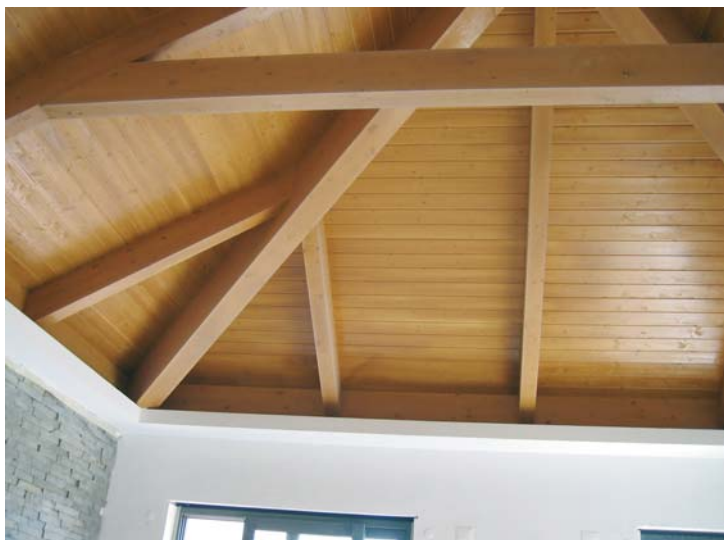
URBANIZACIÓN VALE DO LOBO EL ALGARVE (Portugal)
